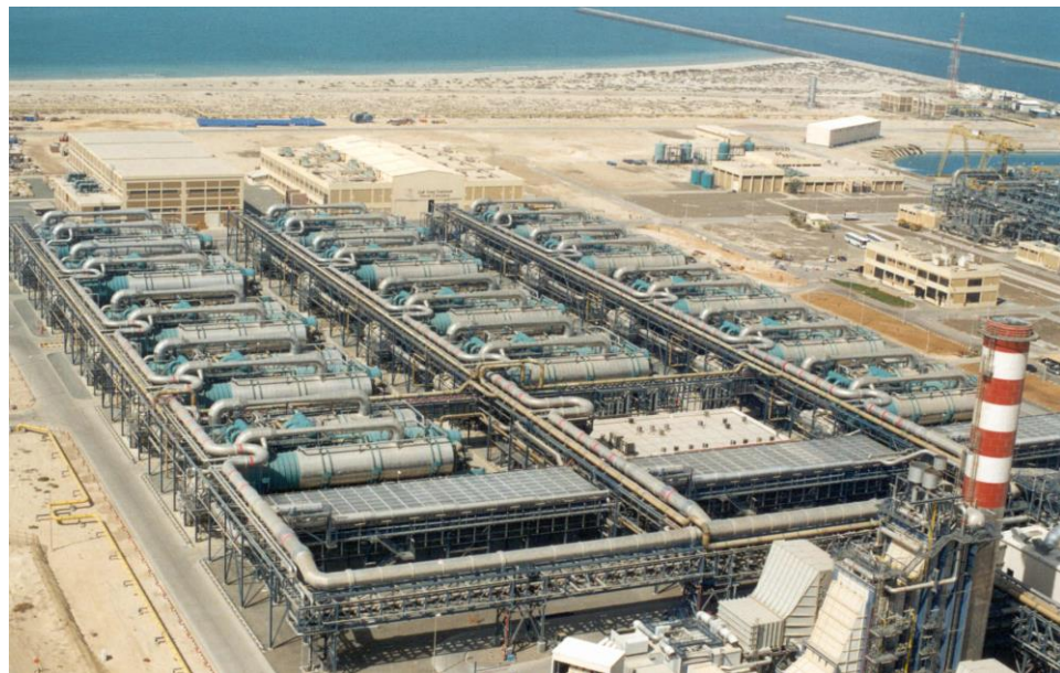
Slika 11. MSF postrojenje u Ras Al-Khairu 15
