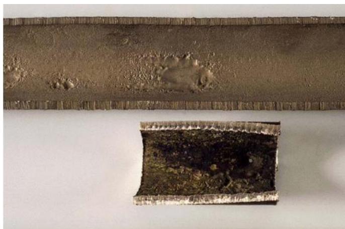
Slika 4. Erozijska korozija CuNi legure 25
