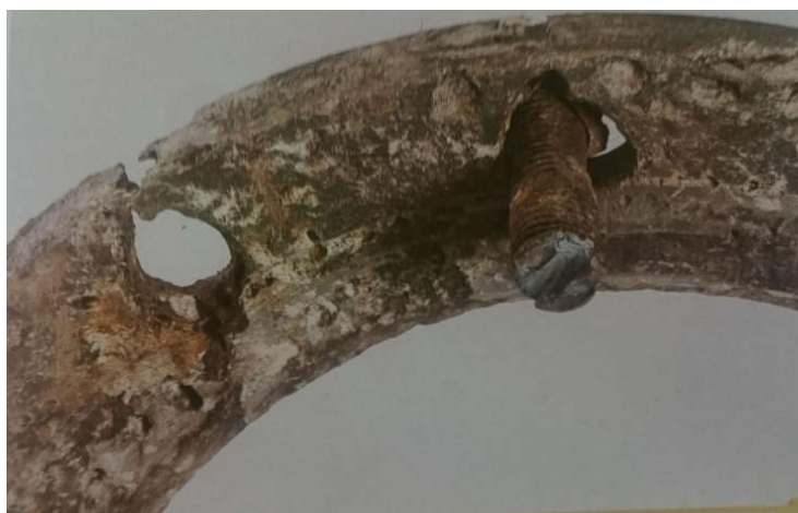
Slika 1.13. Galvanska korozija aluminijske legure 26
